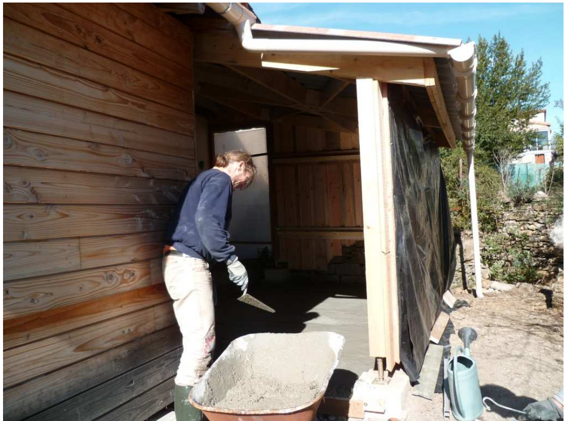
Travaux annexes : coulage d'une dalle
