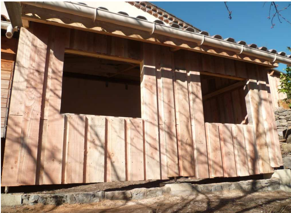
Façade Est avant la pose des fenêtres
