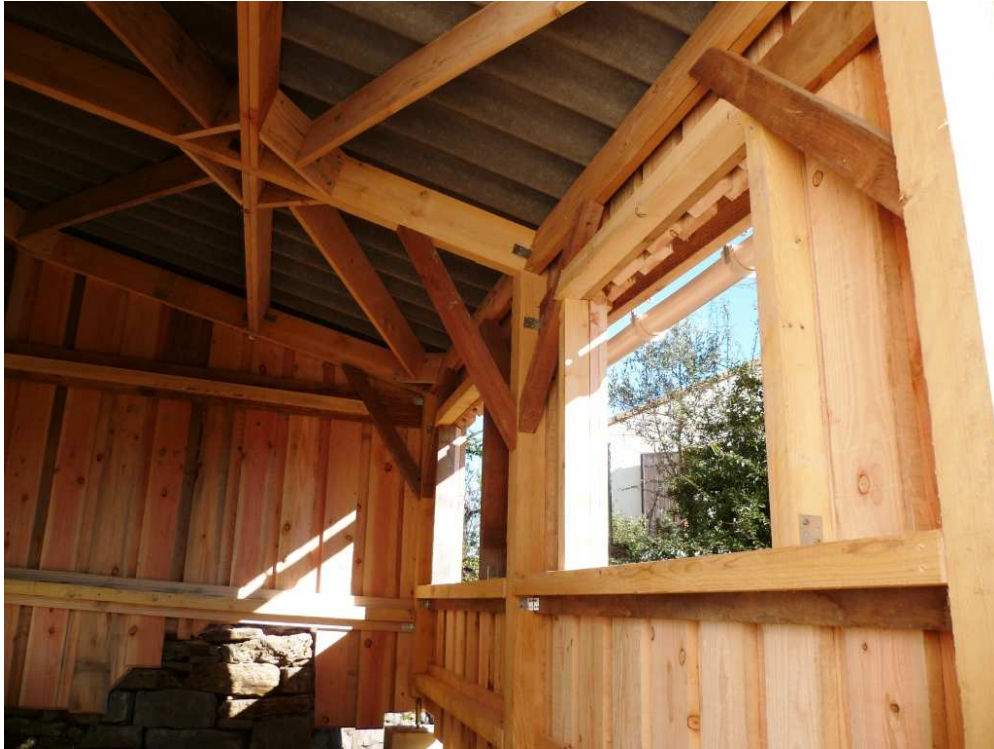
Structure et bardage : pin douglas
