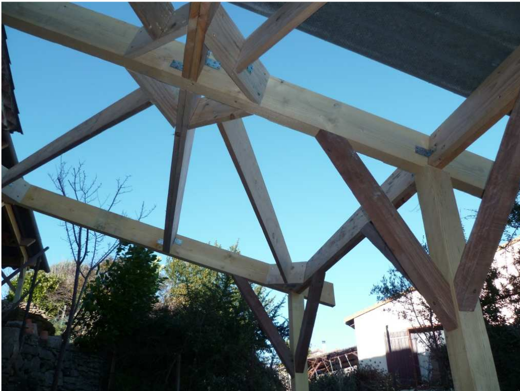
Contreventements en tous sens (Couverture en plaques fibrociment)
