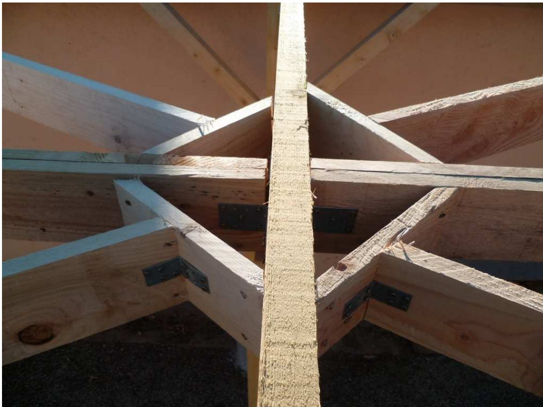
Cœur de la structure vue de dessus
