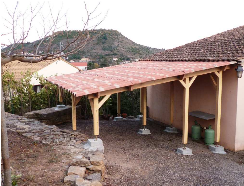
Toiture avant pose bardage
